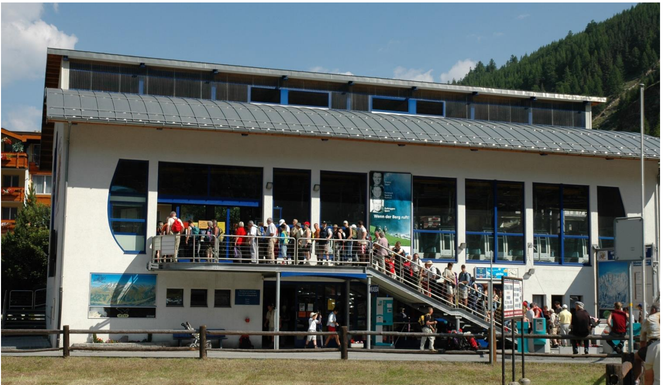
Talstation Bergbahnen Hohnsaas (Andenmatten Bernhard)
